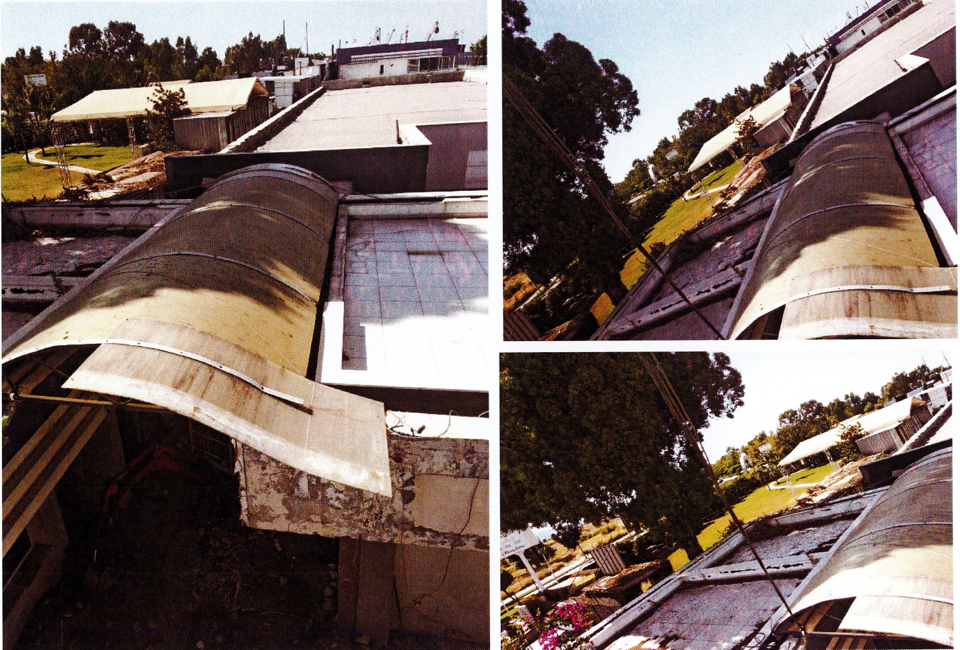
Resim 2.1. İdari bina, Güvenlik görevlisi ve yan binanın aralarında kalan gölgelik/sundurma yapılacak kısımlar
